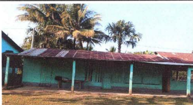
Foto 1: Sustitución de estructura y cubierta de lamina.
