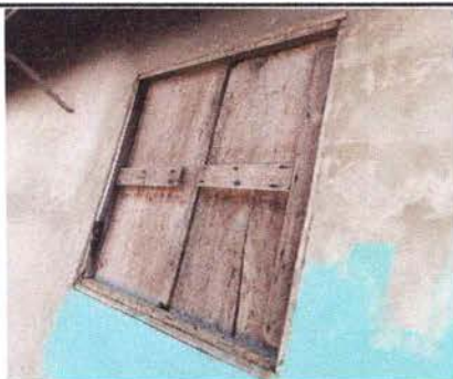
Foto 9: Sustrucción de ventanas de madera por ventana de PVC.
