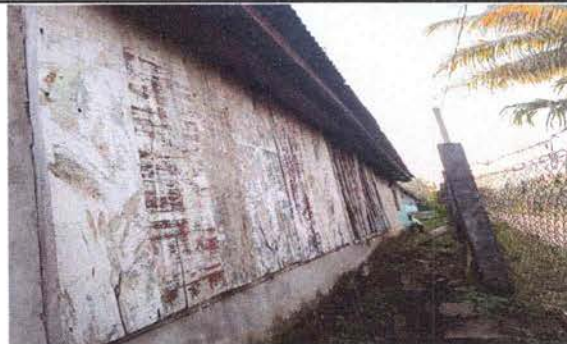
Foto 8: Sustrucción de ventana de madera por balcon de metal e implementación de canales de metal con bajada de agua pluvial.
